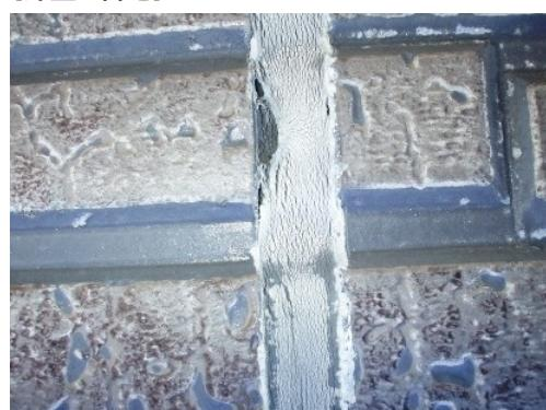
サイディング板の目地のコーティングが、著しくひび割れしていたり、はがれている。
