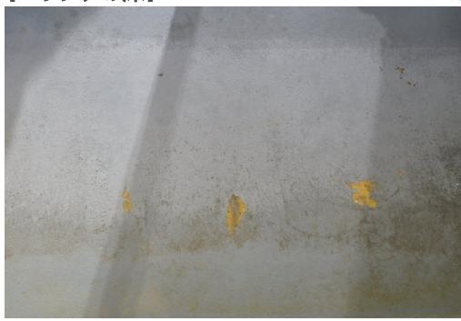
表面の塗装が、ひび割れしていたり、はがれている。
